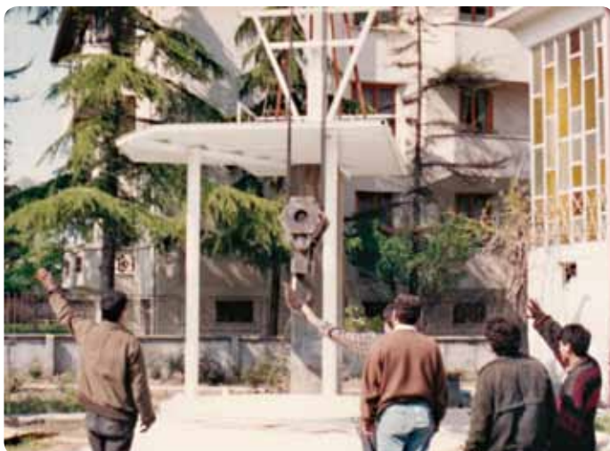
■ Crane mengangkat antena ke tempat pemasangan.
